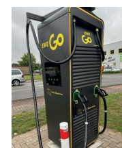
Das Kabelmanagement ist oft nicht optimal.
